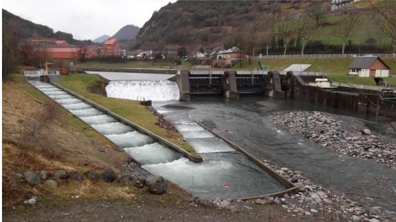
*La passe à poisson et, au second plan, la prise d'eau du canal de la Neste*
